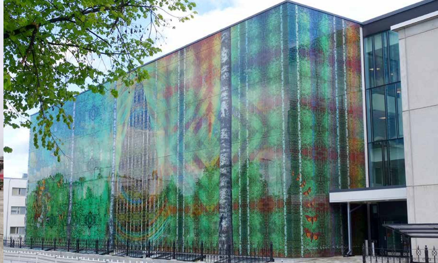
We ontwikkelden een oplossing om glazen gevelbekleding op een volledige onzichtbare manier te kunnen realiseren, niet met verlijming, maar met een revolutionair systeem met mechanische koppeling.
