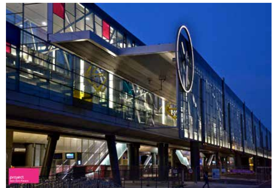
Starconstruct werkte ook de technische oplossingen uit voor de glazen elementen in Gent Sint-Pieters: vloeren, perronoverkappingen, borstweringen, windschermen, zitbanken, liften, wachthuisjes, lichtgevende wanden én de grote achtergevel van het station, inclusief levering en plaatsing van al deze elementen.
