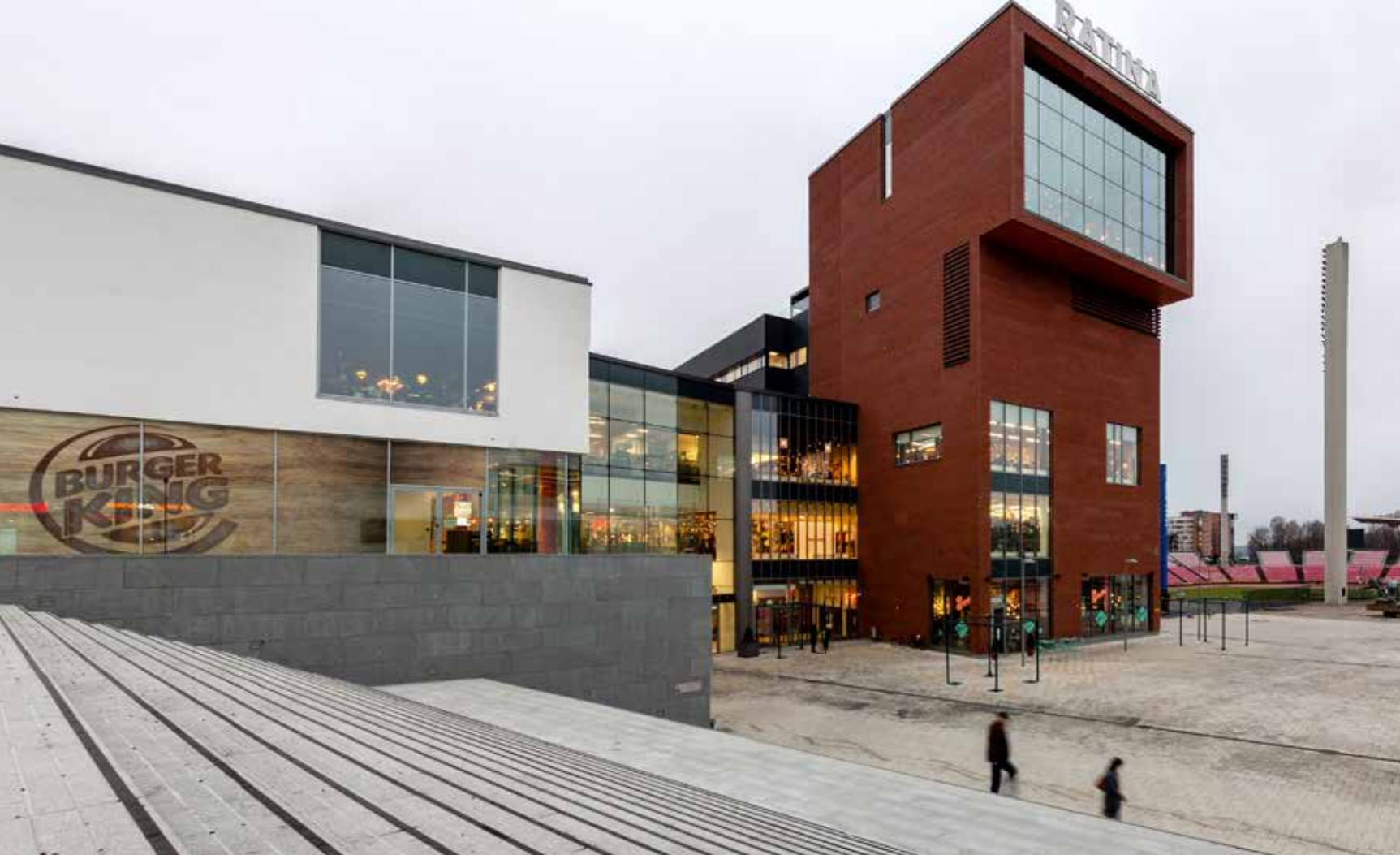
Starconstruct werkte voor het Ratina Shopping Center in Tampere (Finland) een oplossing uit voor een glasgevel in de inkomhal en een hoger gelegen glasgevel bij het periscoop-restaurant.
